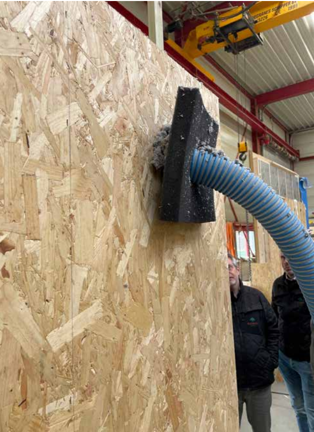
Bij het bouwen met biobased isolatiematerialen zoals houtvezel, stro en cellulose is de keuze voor de juiste buitenplaat cruciaal.
